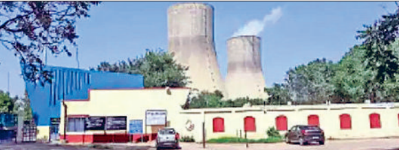
बरवाला। खेदड़ थर्मल प्लांट।
